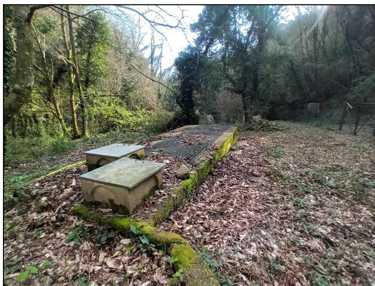
Figura 3.2 - vasca di decantazione (dissabbiatore)
