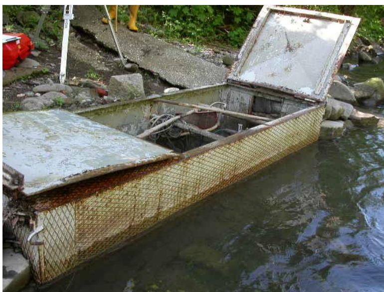
Figura 2 - foto opera di presa
