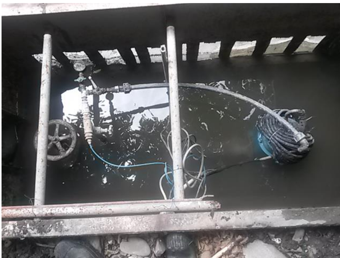
Figura 6 - inquadramento opera di presa
