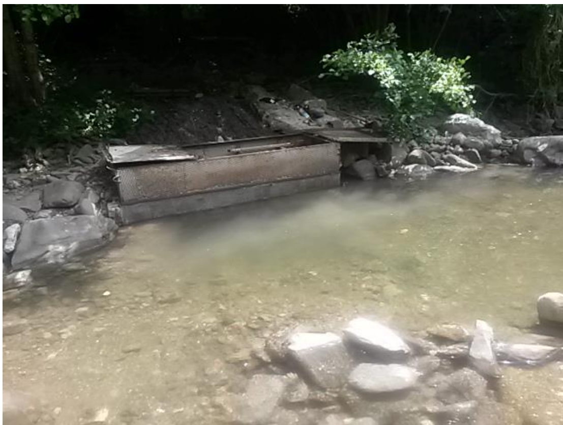
Figura 5 - inquadramento opera di presa
