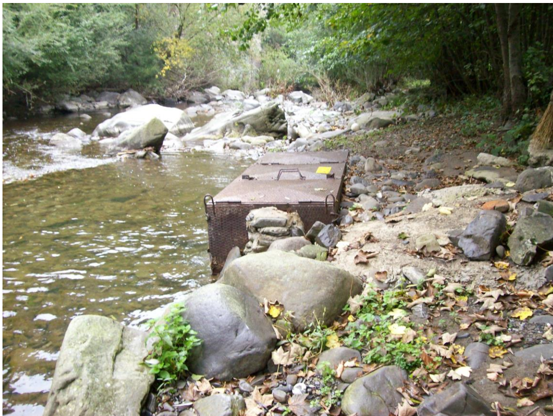
Figura 3 - inquadramento opera di presa
