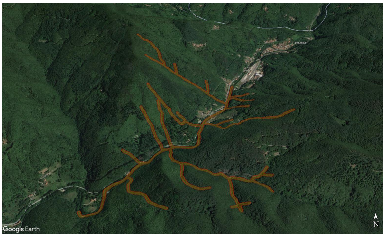
Figura 1 - inquadramento opera di presa
