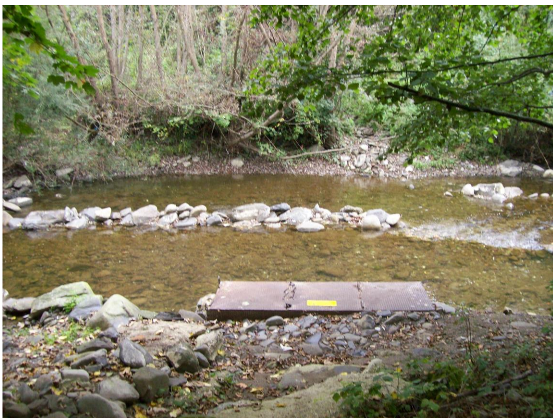
Figura 4 - inquadramento opera di presa
