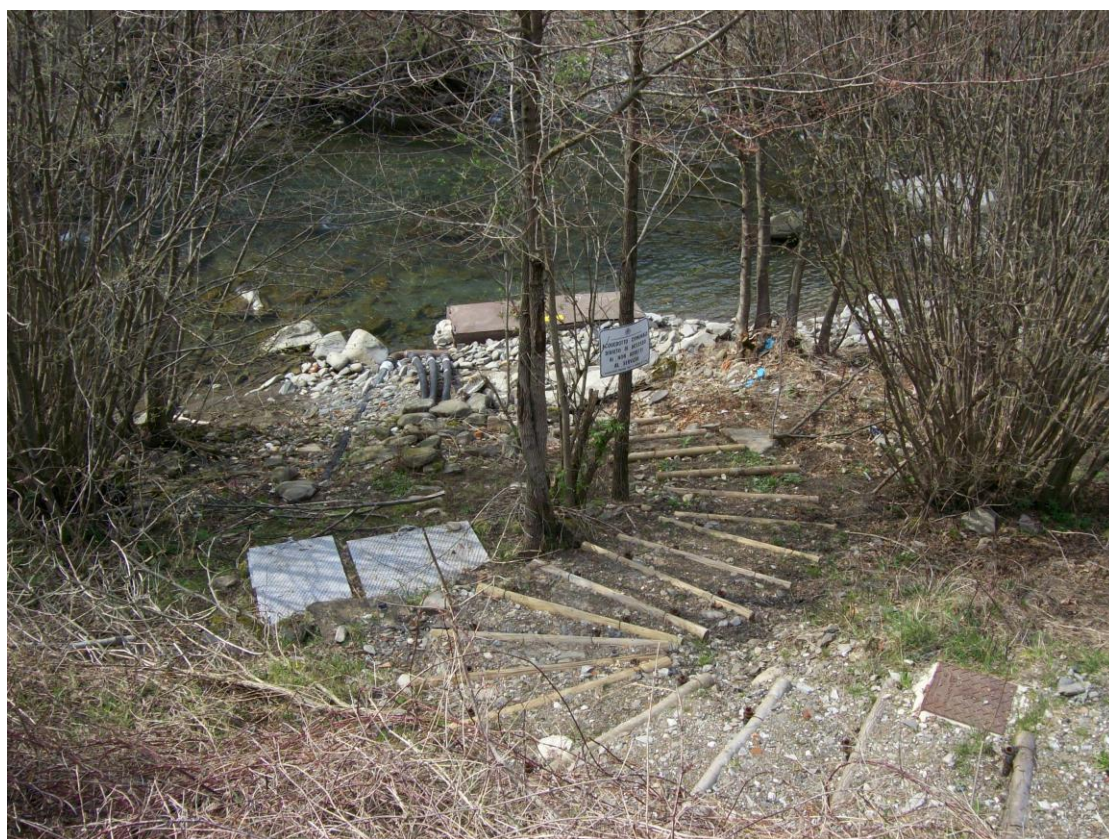
Figura 2 - inquadramento opera di presa
