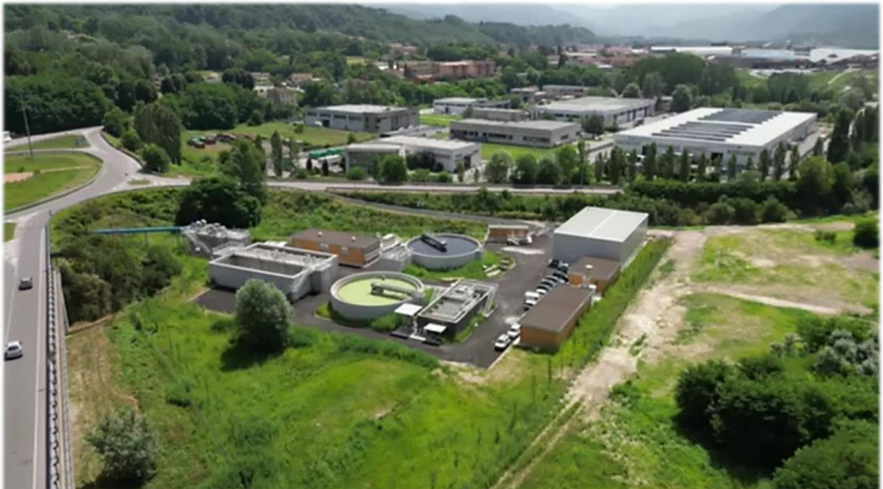
Foto 1: Fotografia aerea nuovo depuratore Chitarrino completato
